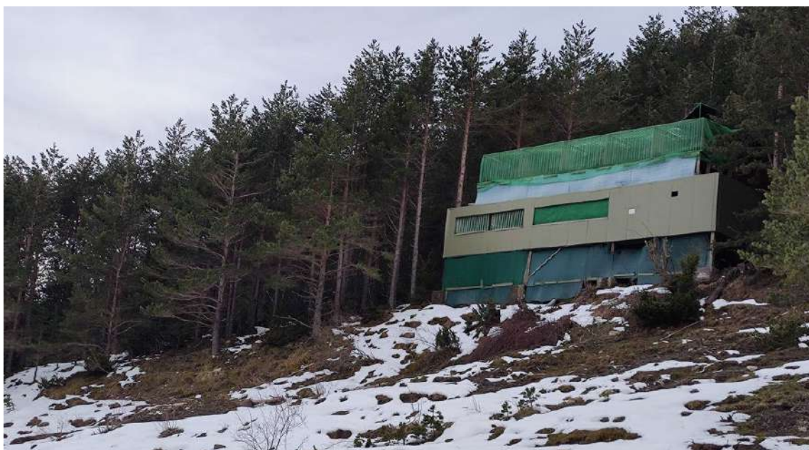
Ilustración 65. Instalaciones del "hacking" del PNOMP.
