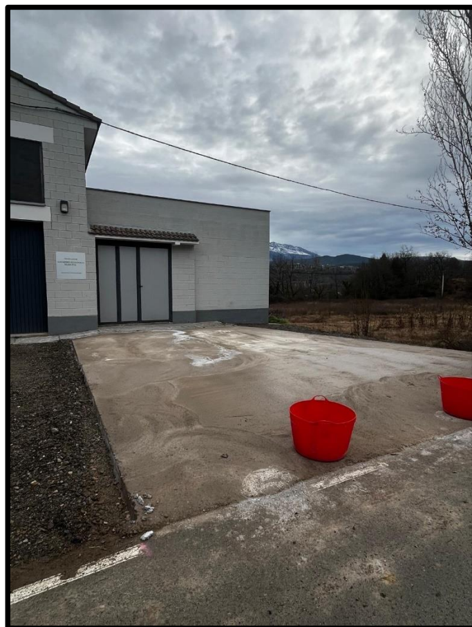
Mejoras en el matadero Municipal de Aínsa-Sobrarbe.
