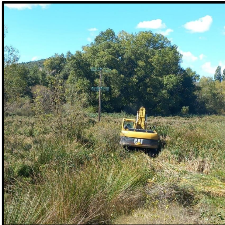
Maquina durante la actuación de mejora.
