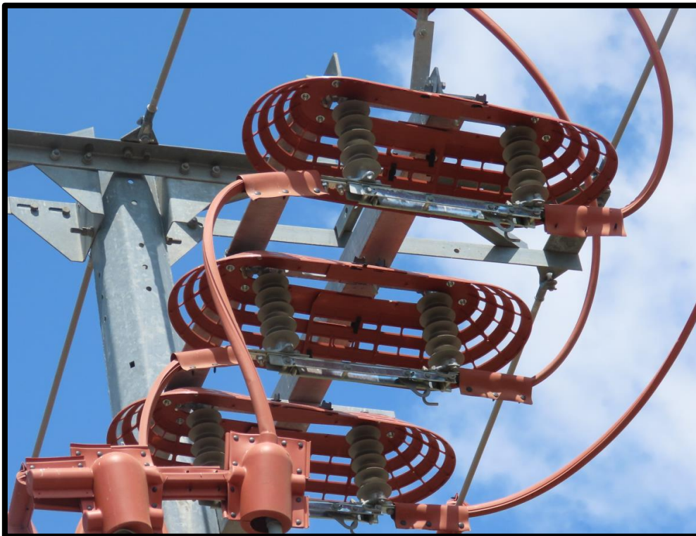
Preformado que protege del contacto por encima a los seccionadores. Fotografía: GREFA.
