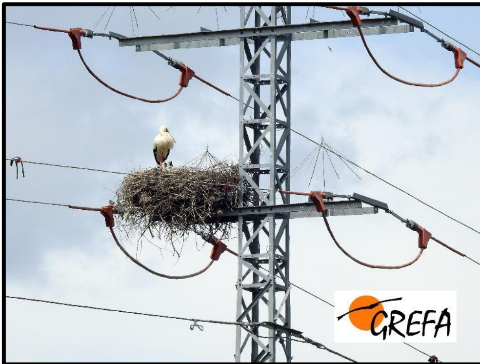
Ineficacia de los elementos anti posada.
