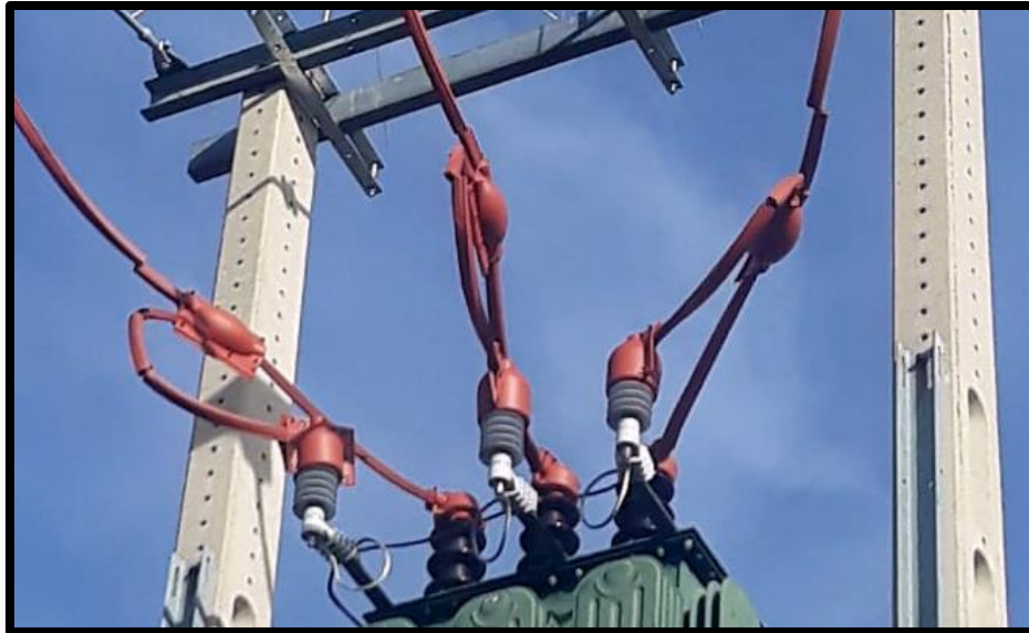
Se han utilizado trozos de forros o vainas, sin utilizarse una tira única por lo que hay múltiples puntos de fuga. Fotografía: GREFA.
