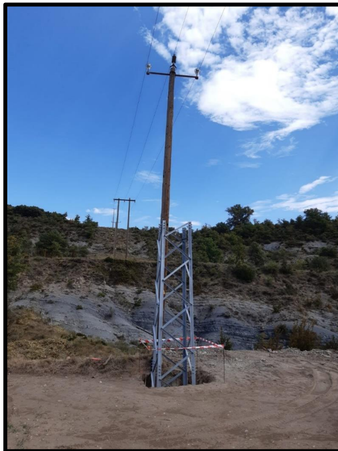
Foto. Actuaciones en el tendido eléctrico octubre 2022.
