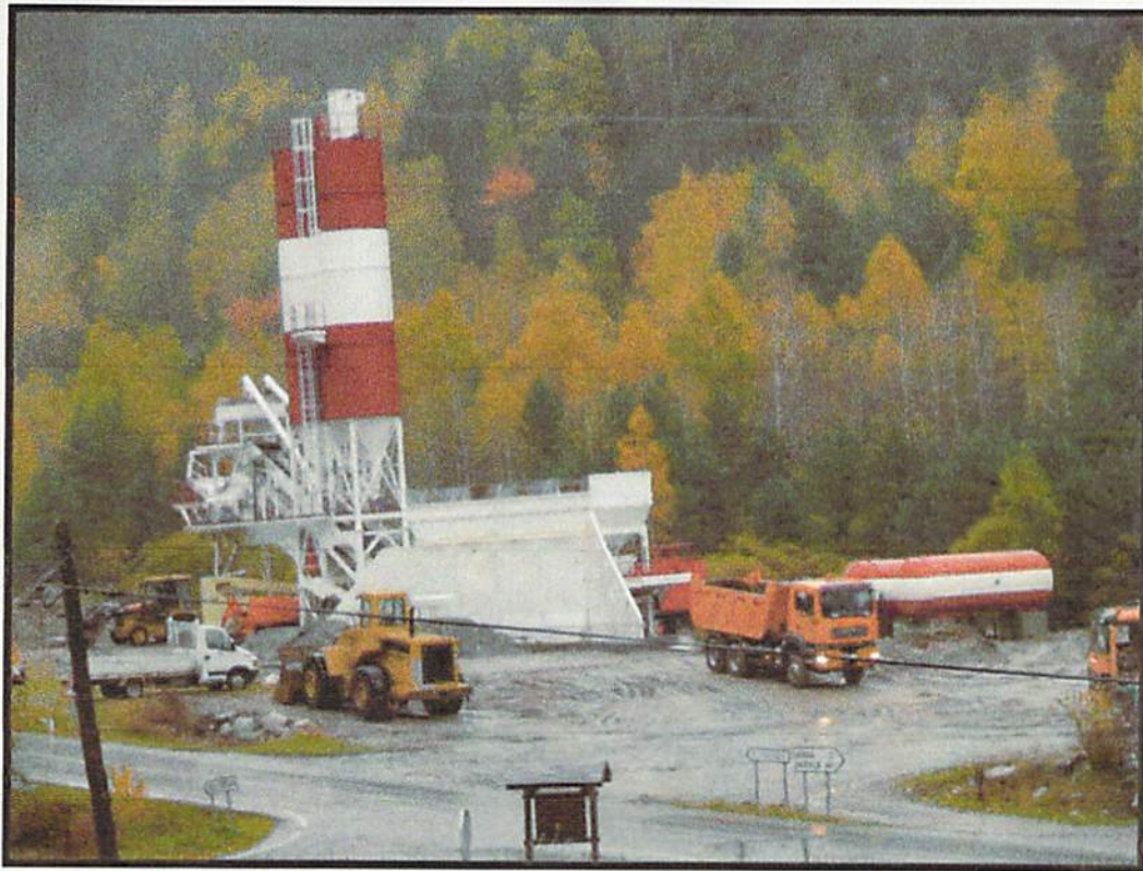
Foto: Planta de áridos de Parzán.
